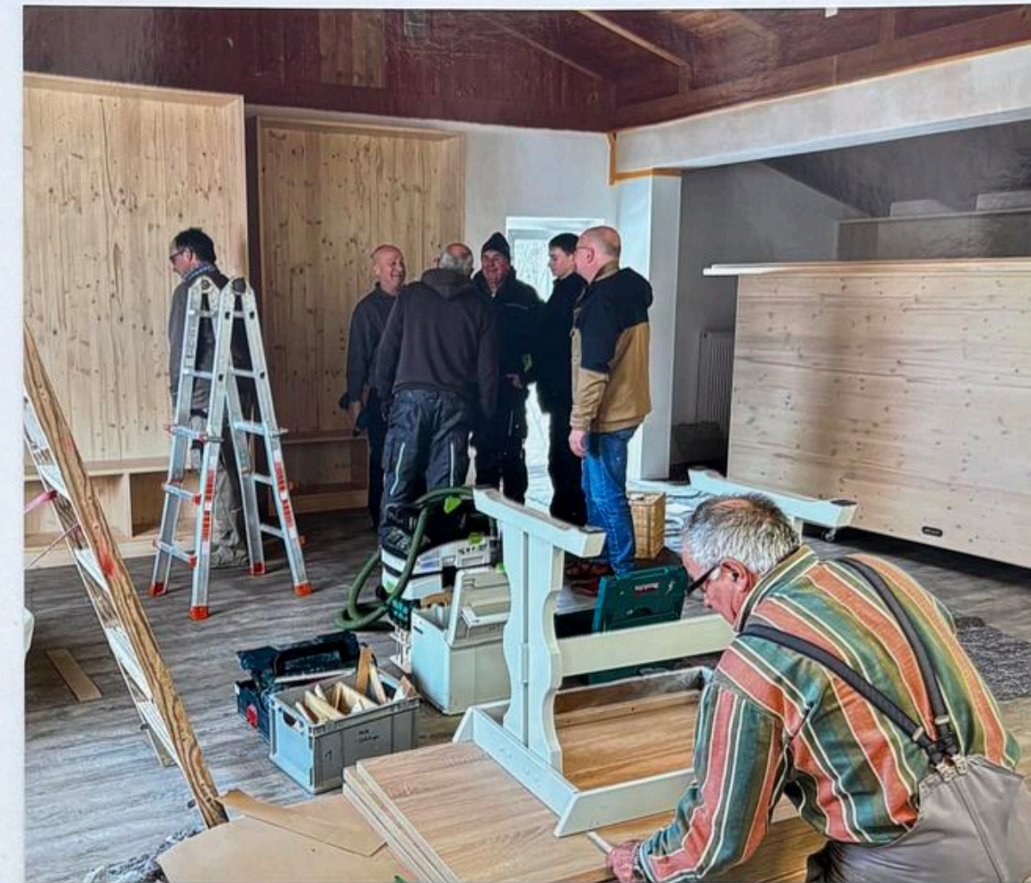
Rudi Reitschuster montierte die neuen Tischplatten.
