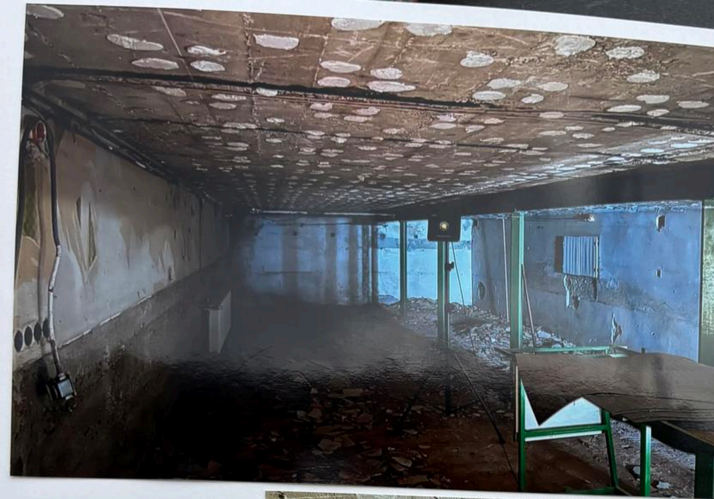
Entkernung im Keller im Schießstand
