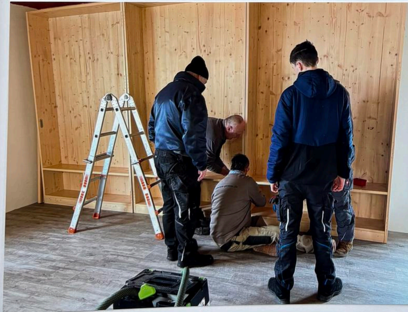
Ende Februar 2026 wurde der Schießschrank wieder aufgebaut.
